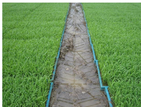
写真2 ハウス内の排水が不良な事例
