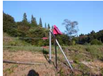
図3 南向きに設置したソーラー発電器
