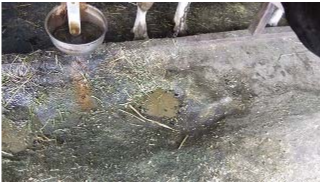
施工前の飼槽。表面が凸凹で水が溜まっている。
