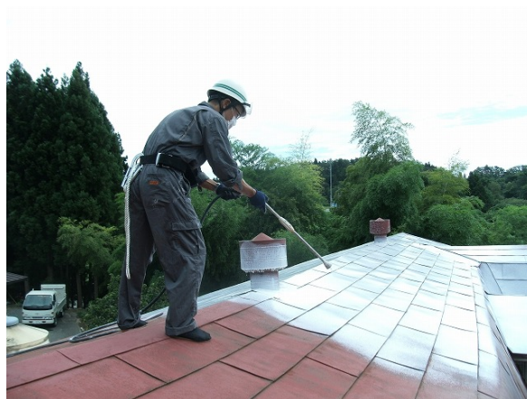
牛舎屋根石灰塗布の様子
