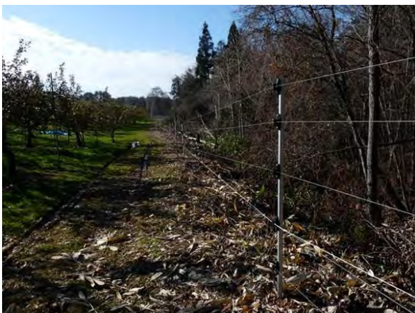
紫波町長岡に設置したフェンシングワイヤー式恒久電気柵
