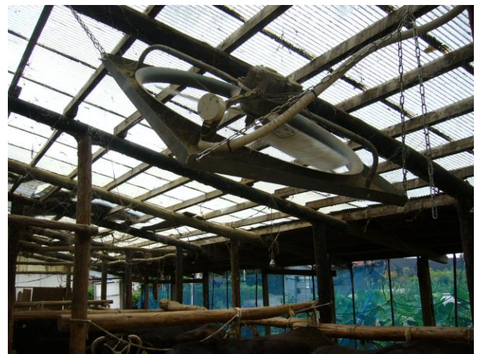
B牧場 換気扇設置の様子
