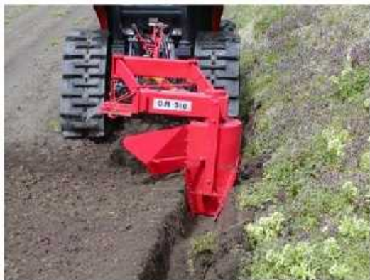
写真1 排水溝（額縁明渠）の設置 排水溝への集水は耕起土層からの流出が多いので、排水溝は耕起深より少なくとも5～10cmは深く掘ることが必要。
