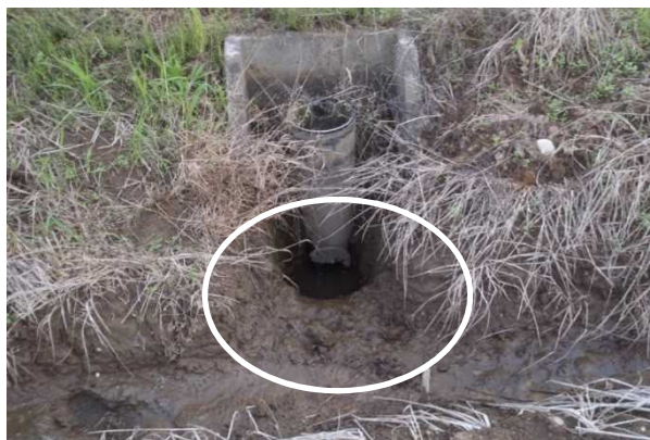
写真2 排水口の掘り下げ 水尻は大きく掘り下げ、排水溝とつなげ、フリードレン下部から排水。
