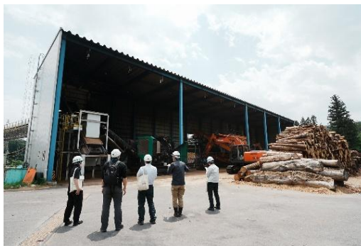
バイオマス発電所
