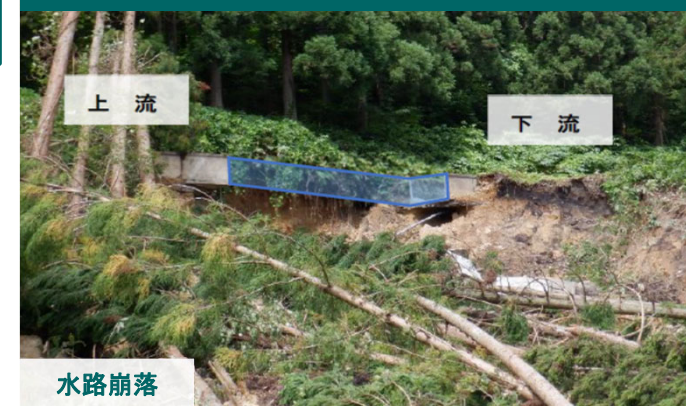
一般県道胆沢金ヶ崎線(金ヶ崎町)
