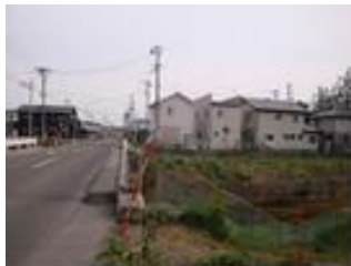
施工前（古館停車場線）
