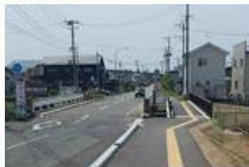
施工後（古館停車場線）
