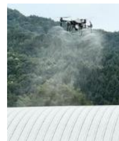
ドローンによる 牛舎屋根への遮 熱材の塗布
