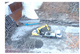
写真-4 土砂溜り積込み状況
