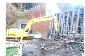
写真-5 流木撤去状況
