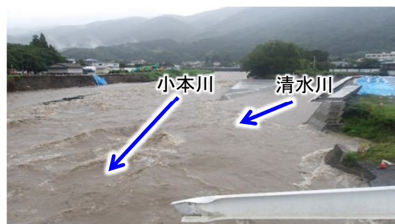
小本川と清水川との合流点付近の出水状況
