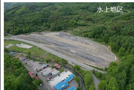
室場地区など24箇所の 残土処理地へ約220万 \text{m}^3 搬出
