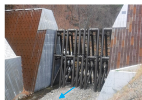
写真-1 松橋川砂防堰堤 (R4. 11月)
