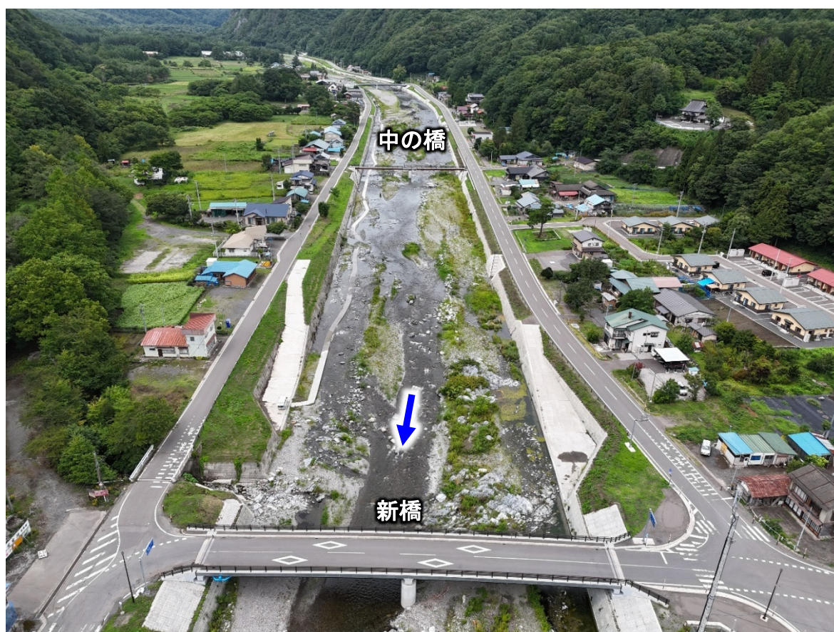
改修後の安家川の状況（R7.9 末撮影）
