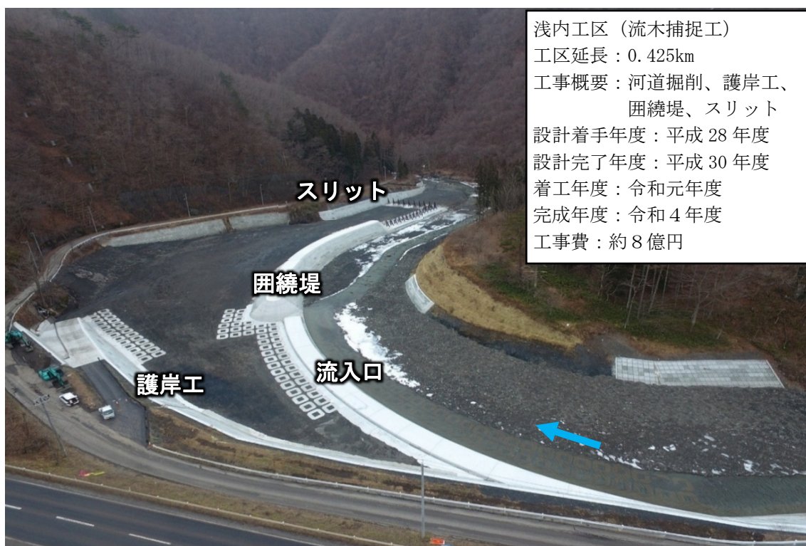
写真 浅内工区完成状況（R5.1 末撮影）
