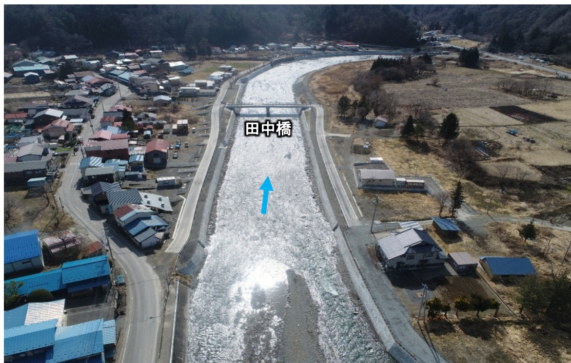
写真 袈綿（中流）工区完成状況（R5.6 末撮影）
