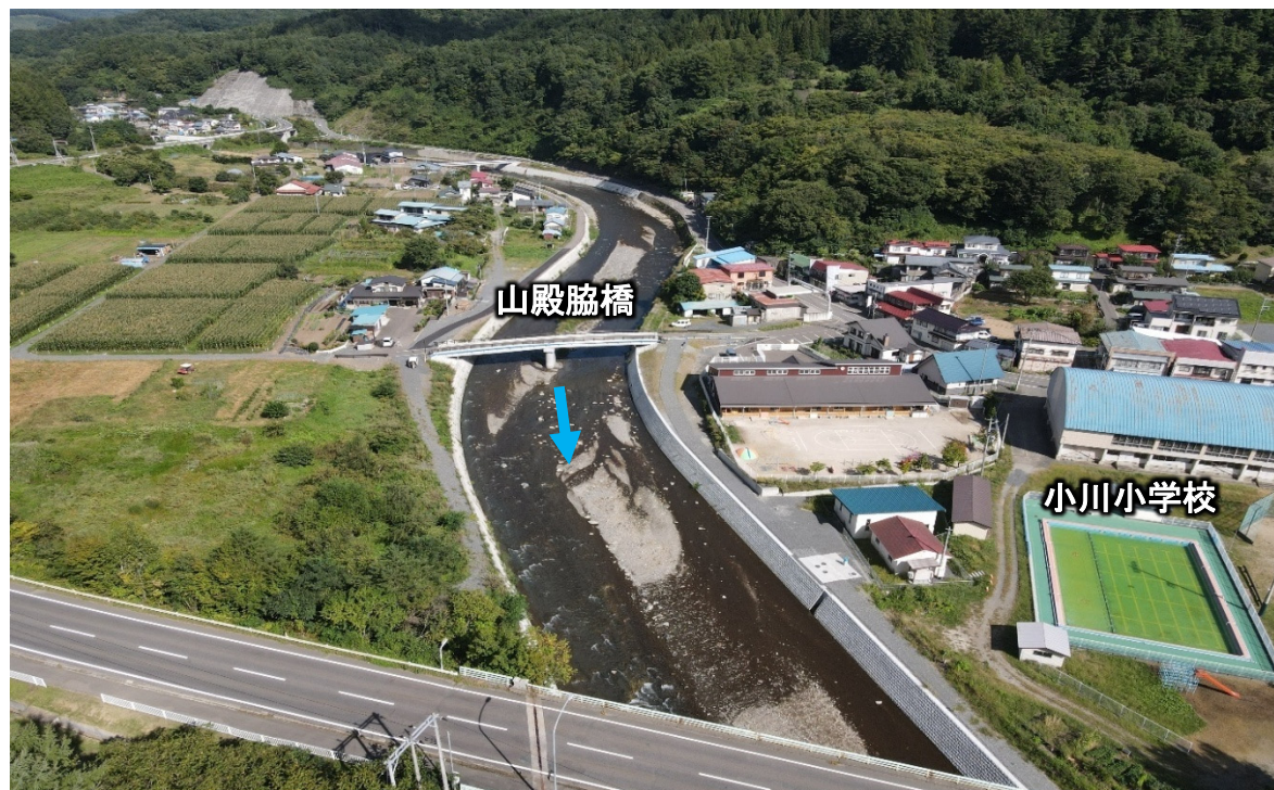
写真 門（上流）工区完成状況（R6.9 末撮影）
