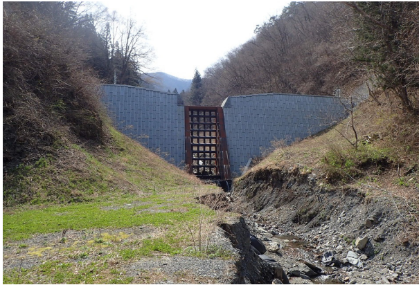
10. 大沢(1)砂防堰堤
