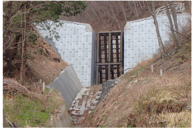
7. 下町の沢(2)砂防堰堤
