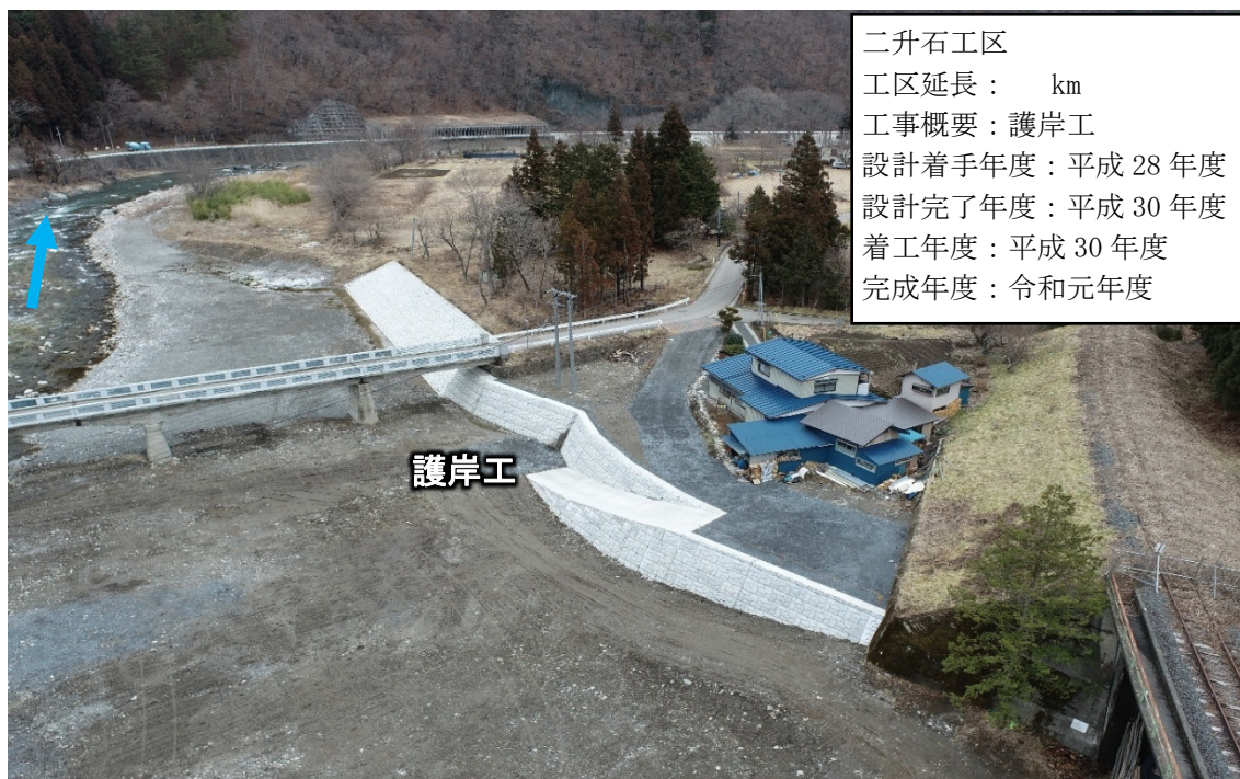
写真 二升石工区完成状況（R2.6 末撮影）
