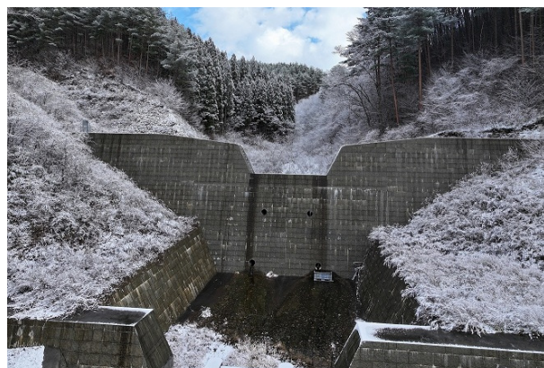
6. 上乙茂の沢(4)砂防堰堤
