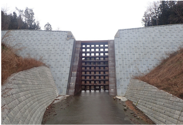
4. 松橋の沢(6)砂防堰堤
