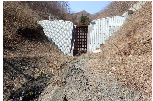
9. 大沢砂防堰堤
