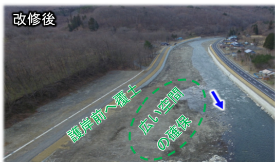
水際利用空間の確保箇所
