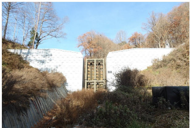
3. 本町の沢砂防堰堤
