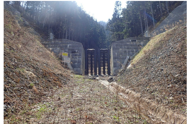
8. 大沢(7)砂防堰堤
