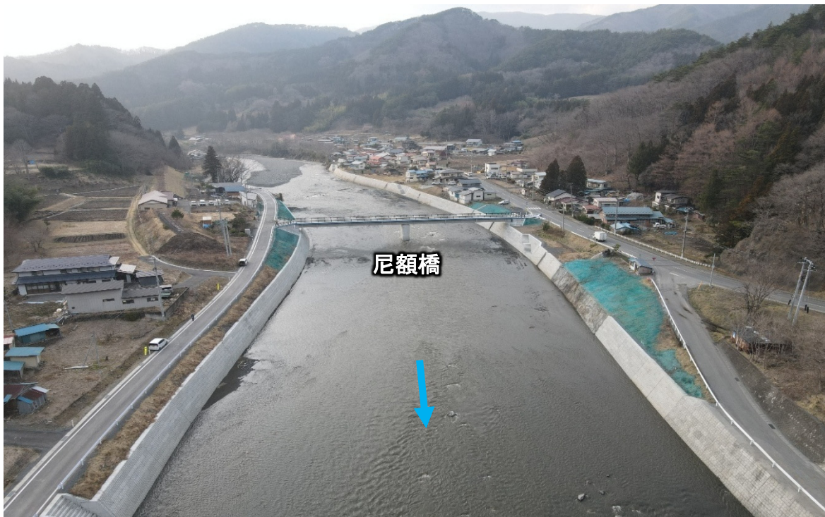
写真 尼額工区完成状況（R7.3 末撮影）
