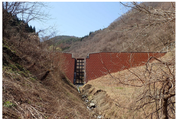
2. 大沢(8)砂防堰堤
