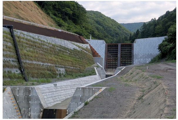
14. 本銅口の沢砂防堰堤
