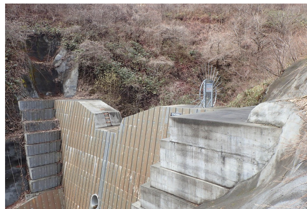
8. 釜津田沢砂防堰堤
