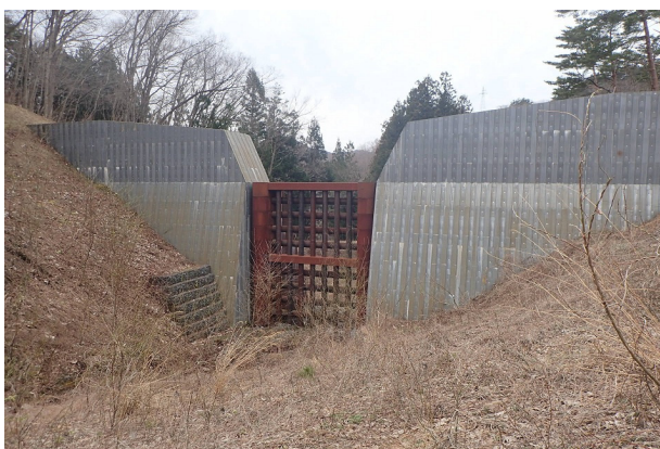
5. 松橋の沢(5)砂防堰堤
