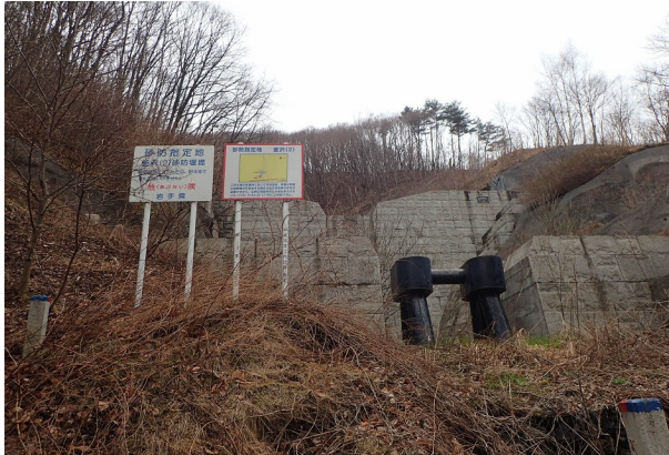
9. 釜沢(2)砂防堰堤
