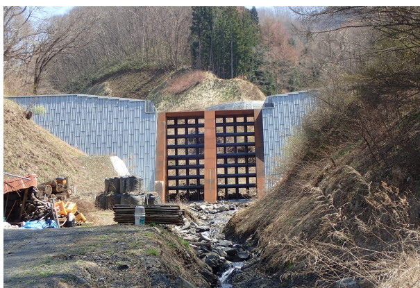
12. 大沢(6)砂防堰堤
