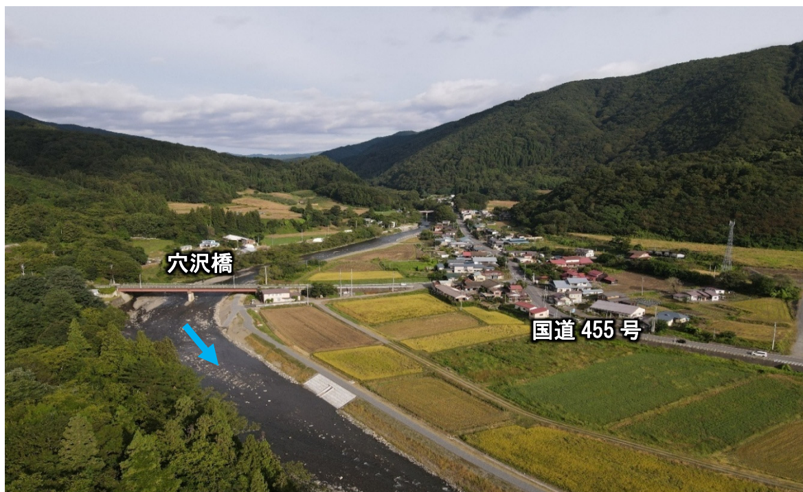
写真 穴沢（袈綿上流）工区完成状況（R5.9 末撮影）
