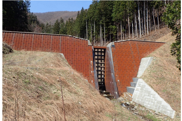
1. 大沢(2)砂防堰堤
