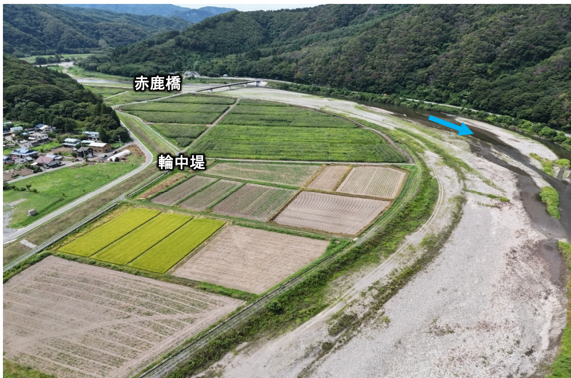
写真 宮本工区完成状況（R7.9 末撮影）
