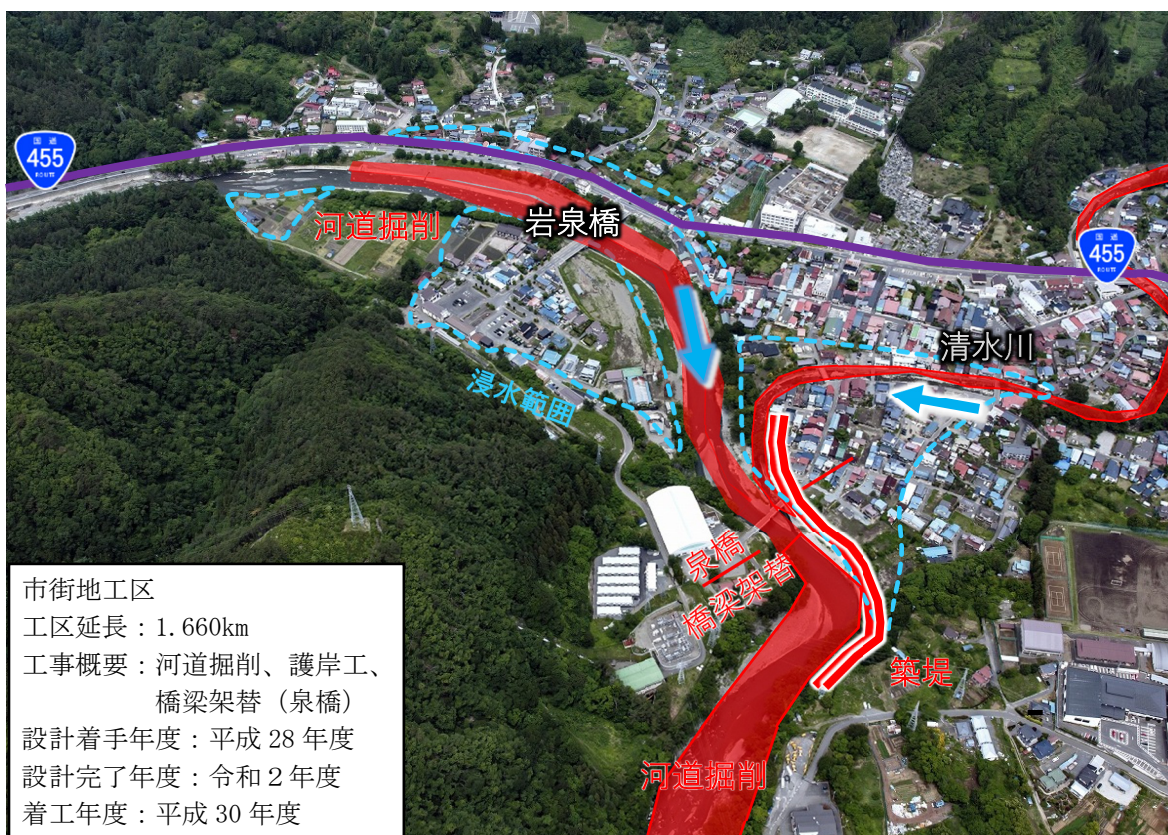
写真 市街地工区工事概要（H29.6 末撮影）
