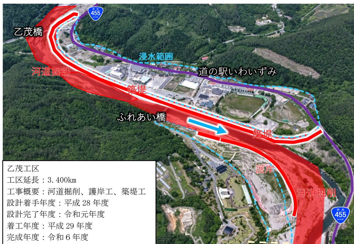
写真 乙茂工区工事概要（H29.6 末撮影）
