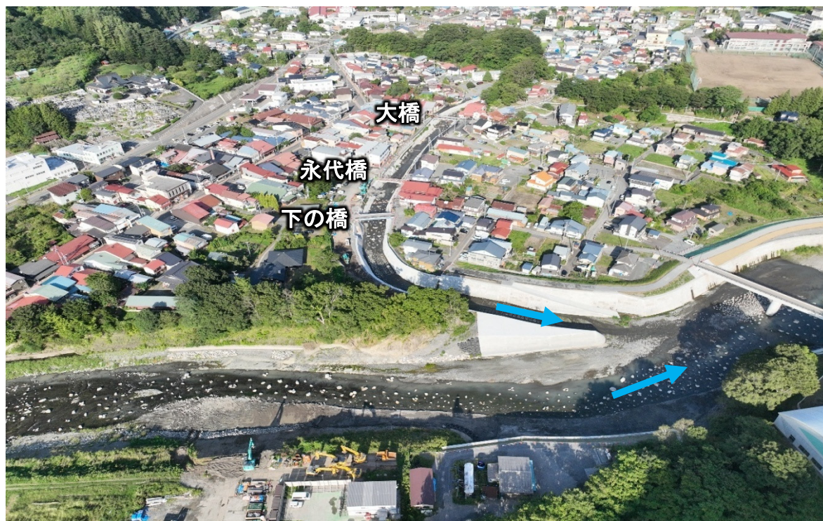
写真 清水川（下流）工区完成状況（R7.9 末撮影）
