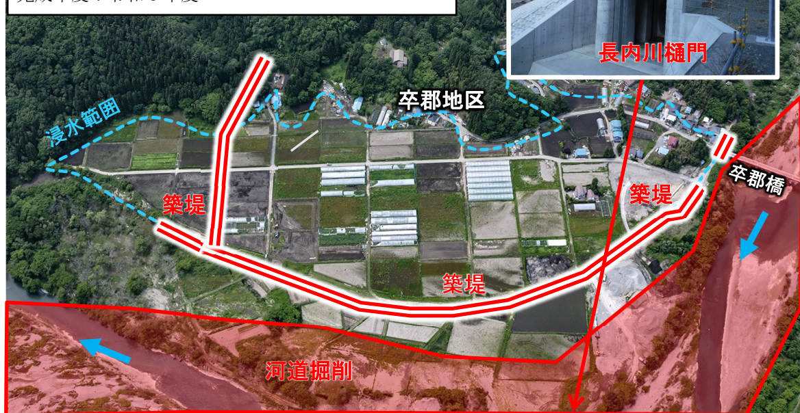
写真 卒郡工区工事概要（H29.6 末撮影）
