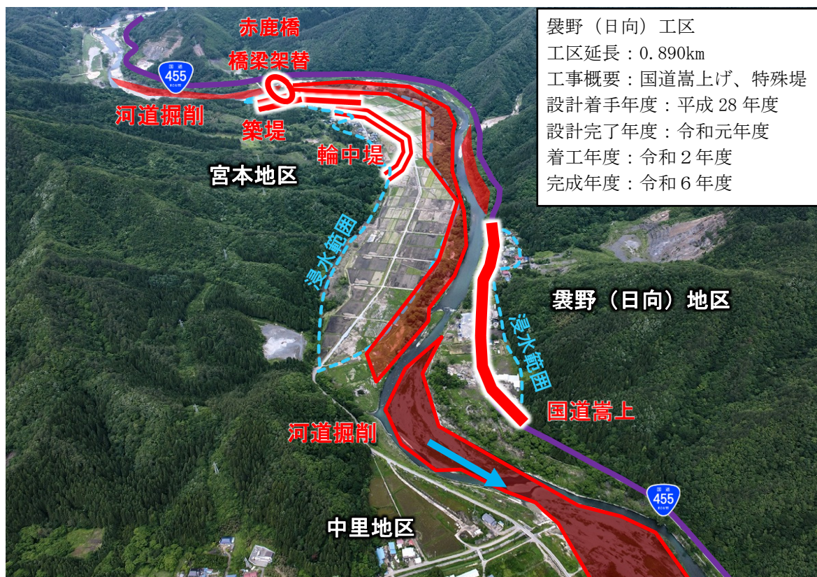
写真 褒野（日向）工区工事概要（H29.6 末撮影）
