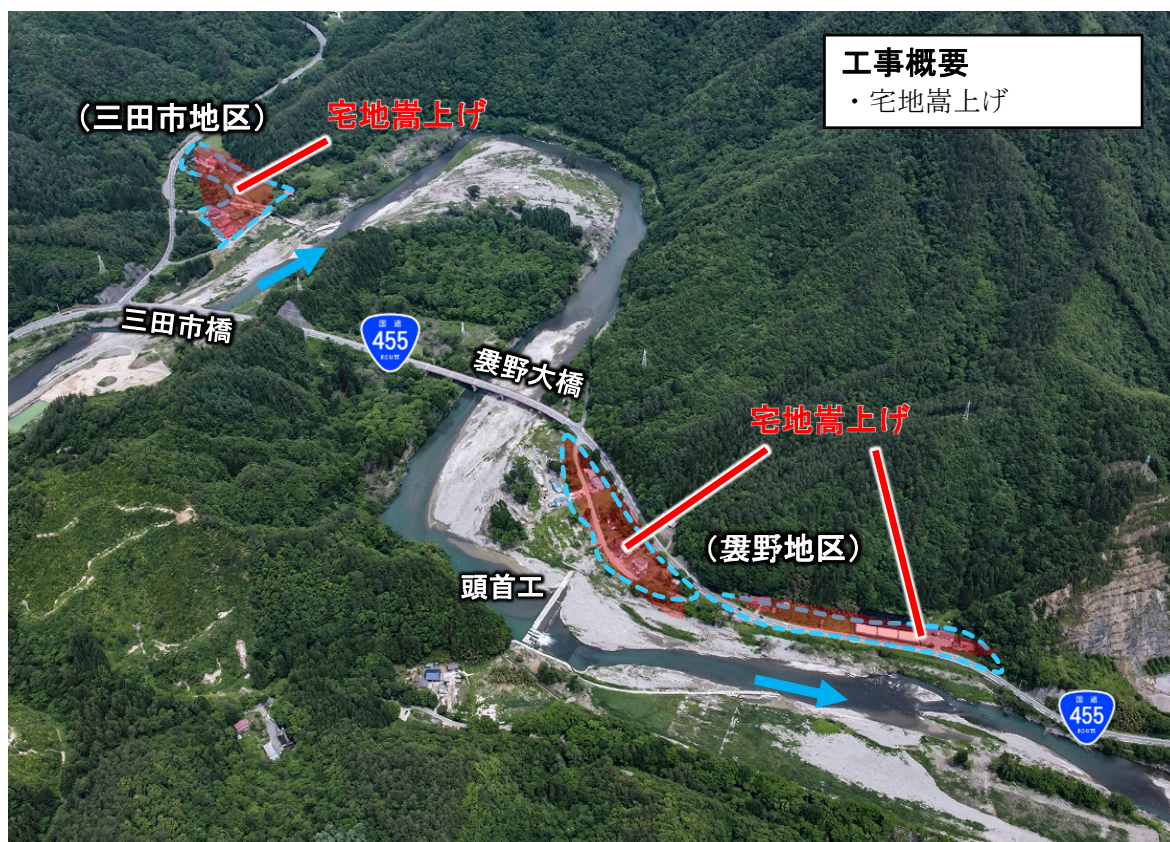
写真 褒野（褒野・三田市）工区工事概要（H29.6 末撮影）
