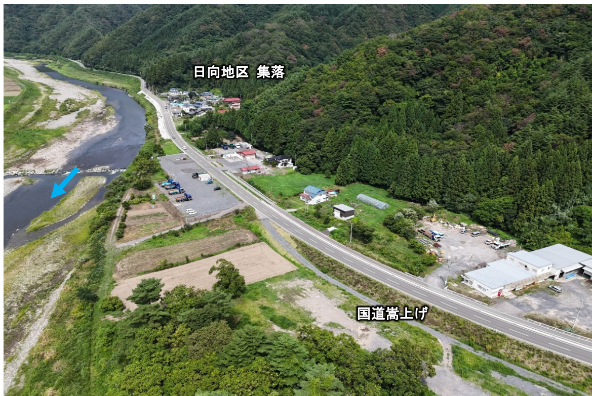
写真 褒野（日向）工区完成状況（R7.9 末撮影）
