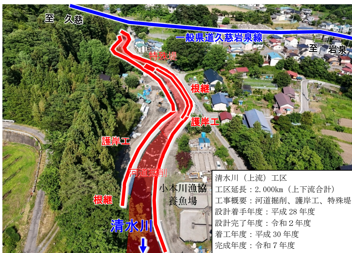
写真 清水川（上流）工区工事概要（R7.6 末撮影）
