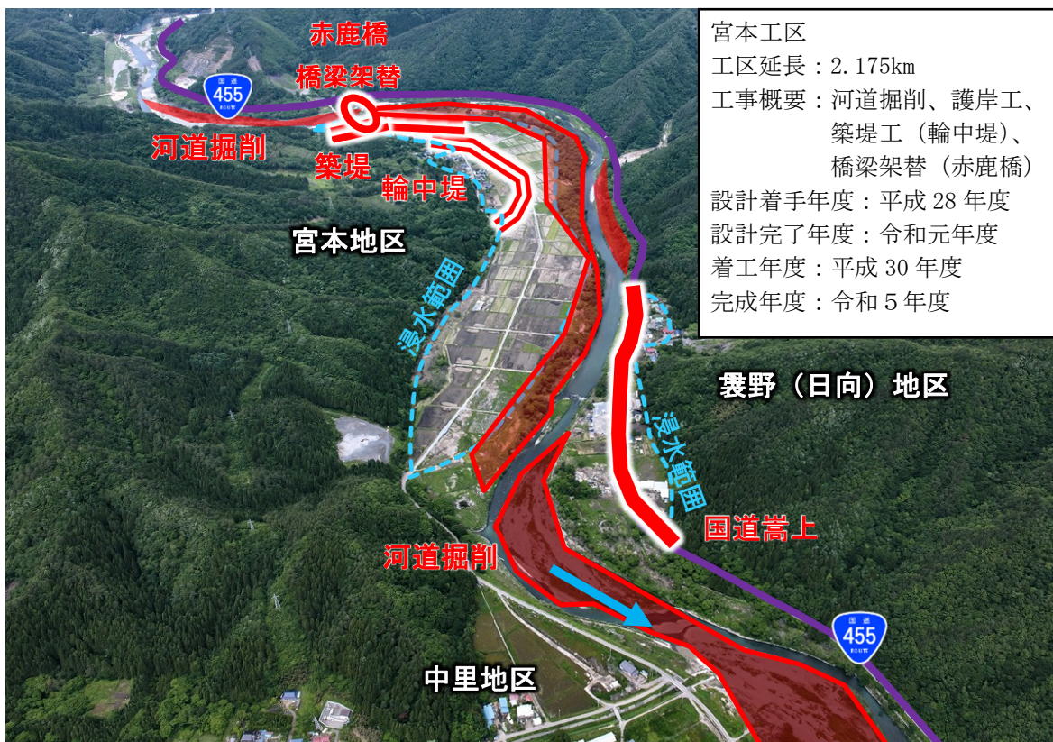
写真 宮本工区工事概要（H29.6 末撮影）
