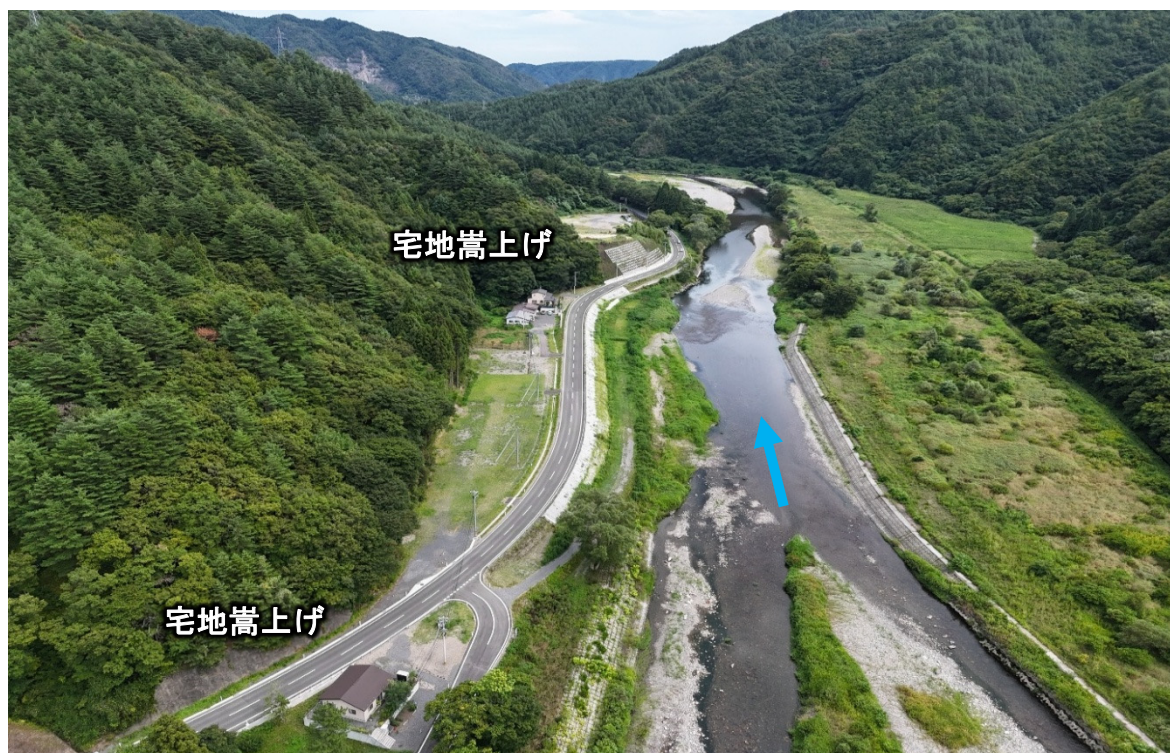
写真 褒野（褒野・三田市）工区完成状況（R7.9 末撮影）
