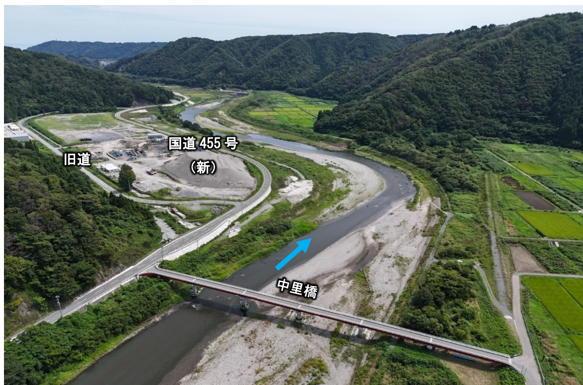
写真 中里工区完成状況 (R7.9 末撮影)
