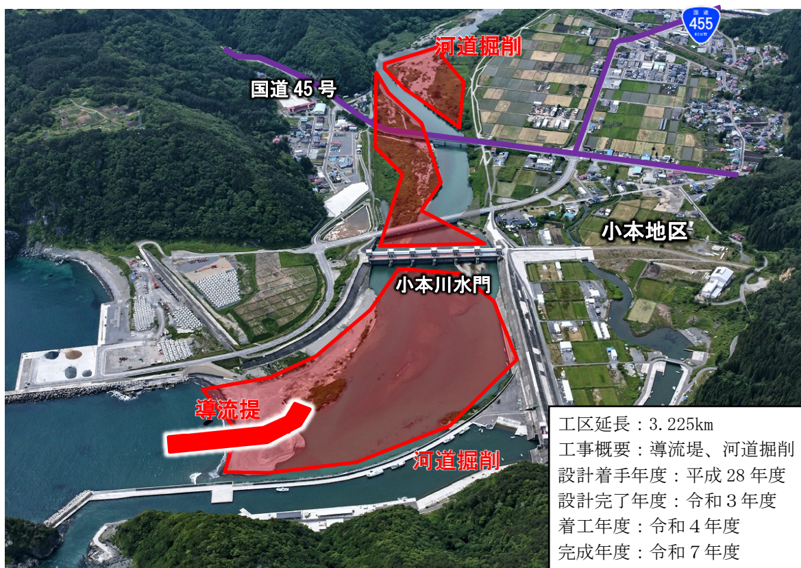
卒郡（小本）工区工事概要（H29.6 末撮影）
