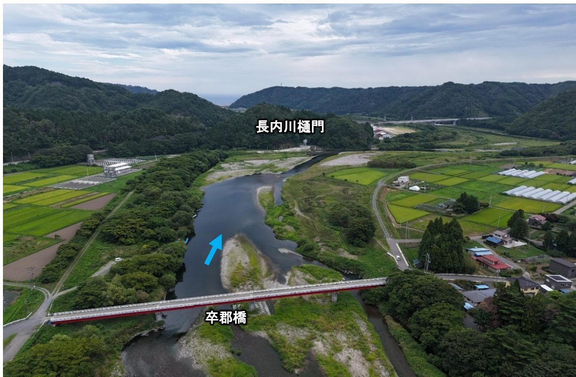
写真 卒郡工区完成状況（R7.9 末撮影）
