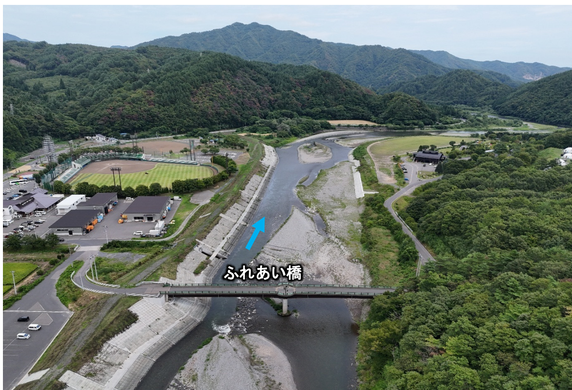
写真 乙茂工区完成状況（R7.9 末撮影）
