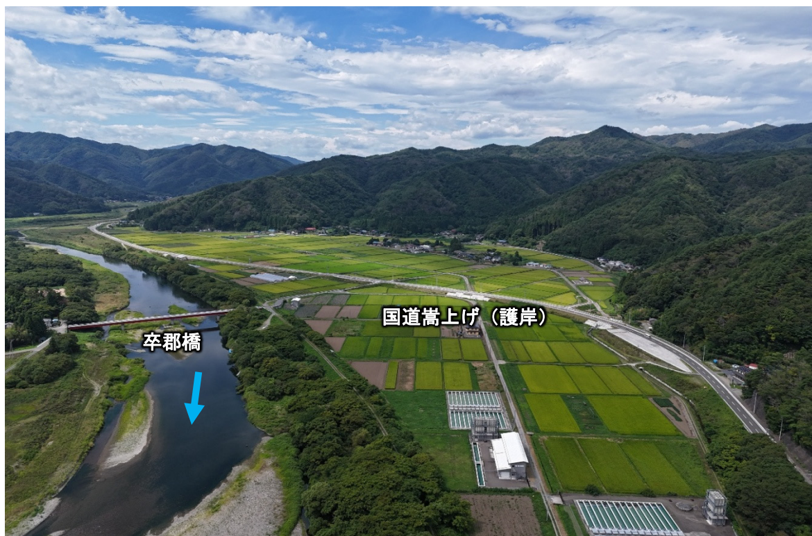
写真 中島工区完成状況（R7.9 末撮影）
