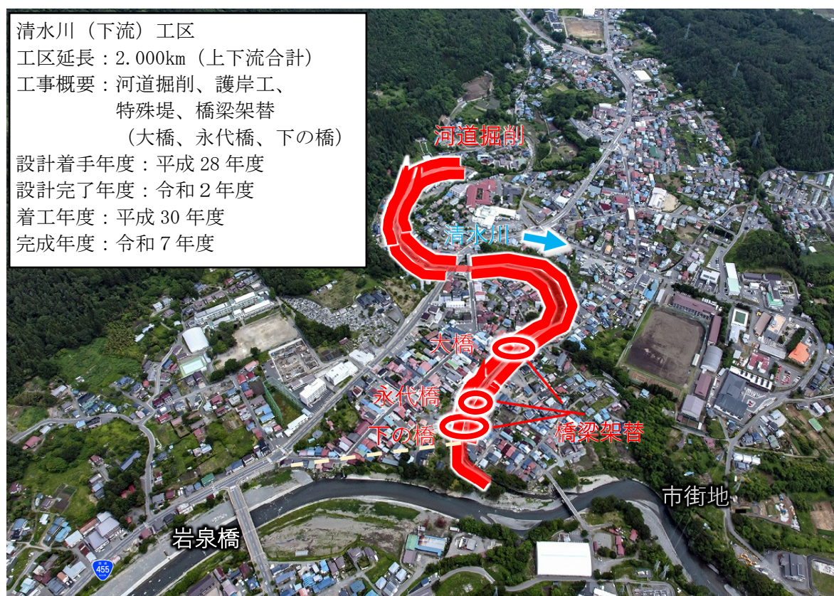
写真 清水川（下流）工区工事概要（H29.6 末撮影）
