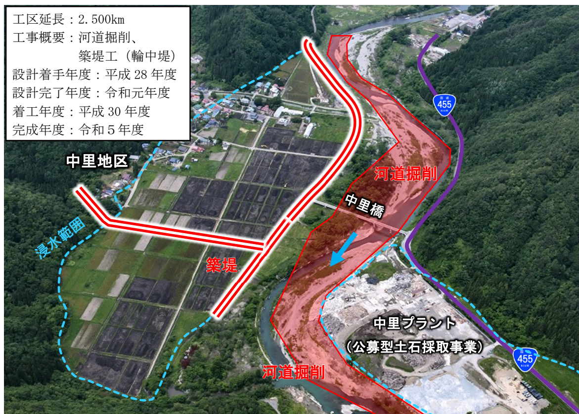
写真 中里工区工事概要 (H29.6 末撮影)
