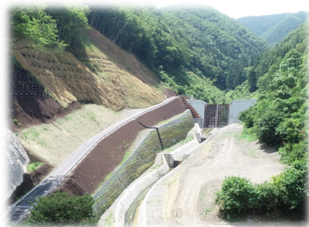
本銅口の沢・砂防堰堤
