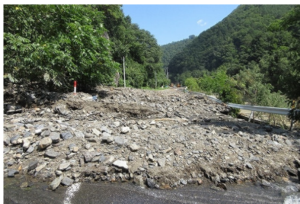
土砂流出状況 （国道 340 号：大川地区）
