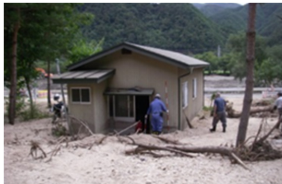
人家被災状況（上乙茂の沢(4)）
