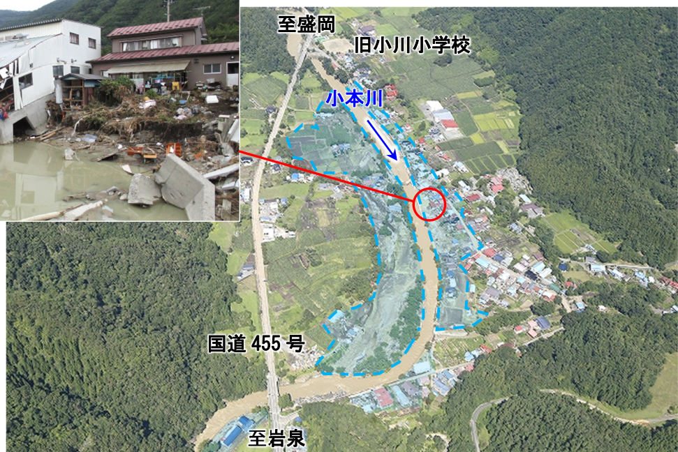
浸水被害状況（褰綿地区）
