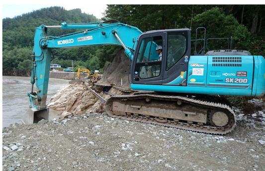
道路啓開作業状況（H28. 9. 3）
