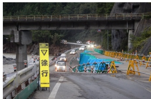
応急工事による規制状況（H28. 9）
