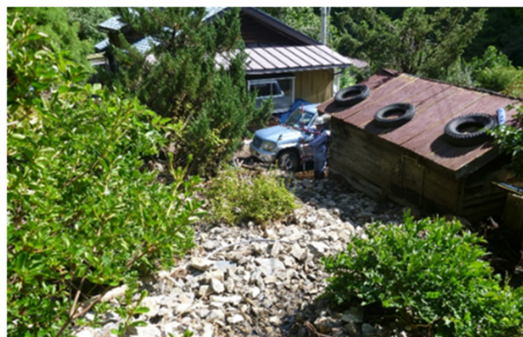
人家被災状況（松林の沢(4)）
