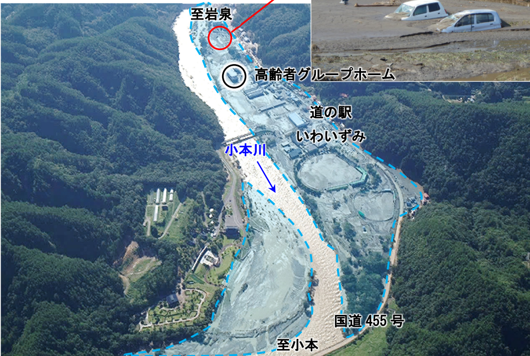
浸水被害状況（乙茂地区）
