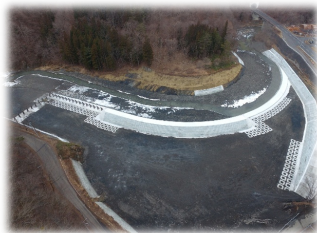
小本川・流木捕捉施設
