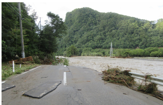
国道 455 号被災状況（H28. 8. 31）
