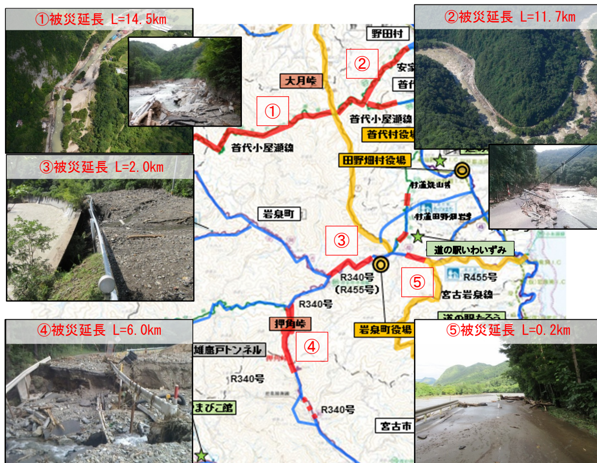
道路の被害状況（岩泉管内の県管理道路）
