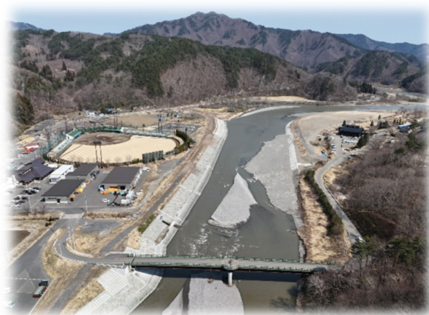
小本川・乙茂地区・護岸工
