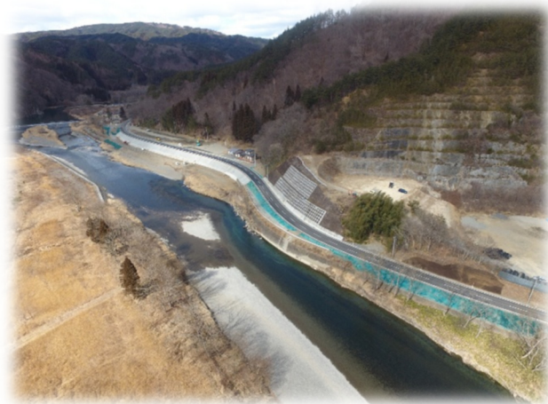
国道 455 号・褒野地区・国道嵩上げ
