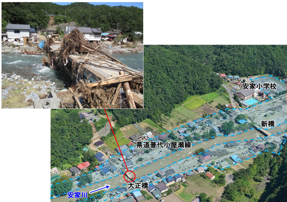
浸水被害状況（安家地区）
