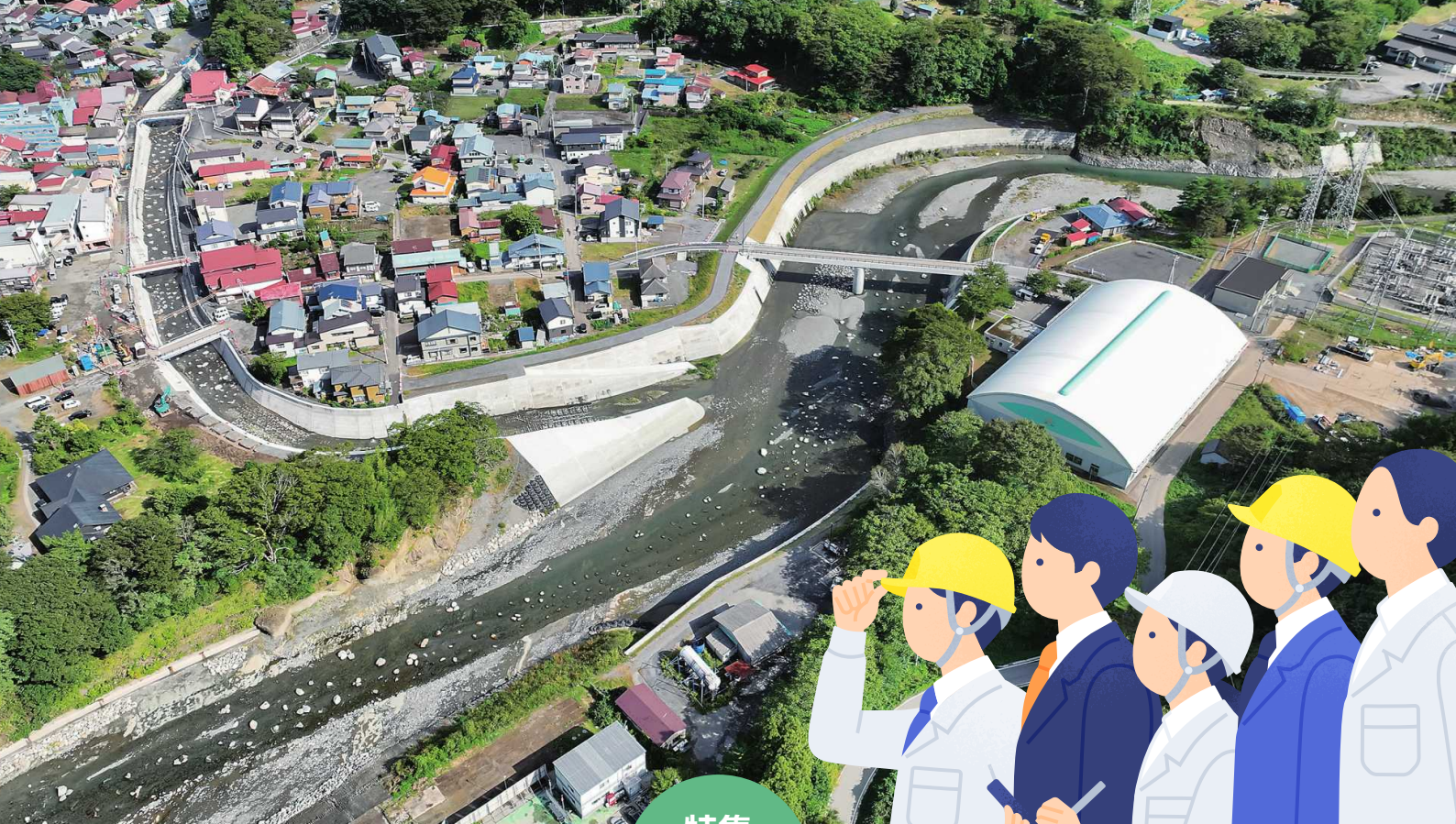
平成28年台風第10号で被災した小本川の河川改修 (岩泉町・令和7年10月全区完了)
