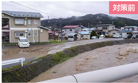
久慈市小屋畑川の被害状況
