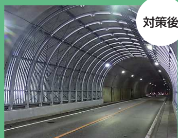
腐食が進んでいた部材を修繕・更新(宮古市柏木スノーシェルター)
