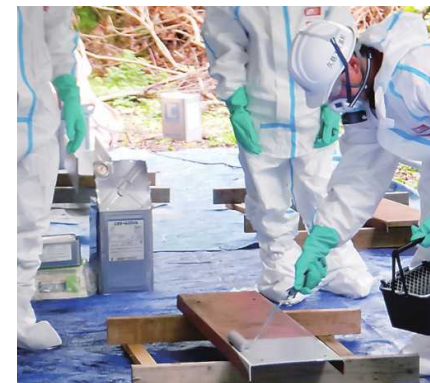
高校生による鋼材の塗装体験の様子（久慈市・小田瀬橋）
