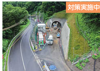
久慈市案内〜戸呂町口地区の工事状況
