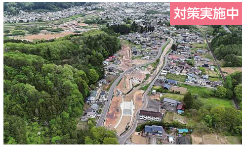
久慈市小屋畑川の工事の状況
