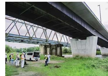
橋梁点検の様子（盛岡市・徳田橋）
