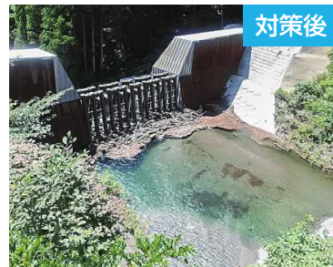
岩泉町の松橋川砂防堰堤
