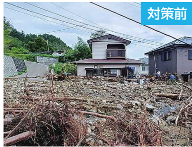
普代村普代の沢の被害状況
