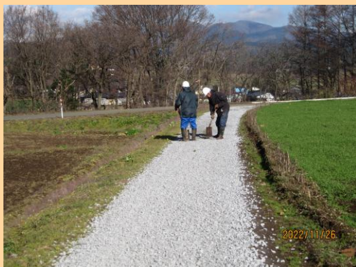
直営施工による農道の碎石舗装
