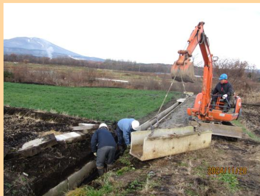
直営施工による水路のコンクリート化
