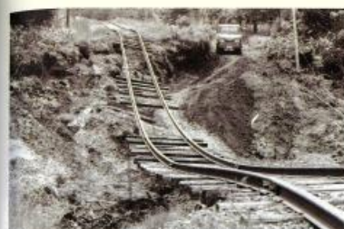
図6-43 十勝沖地震で線路が破壊された南部鉄道(五戸町)
