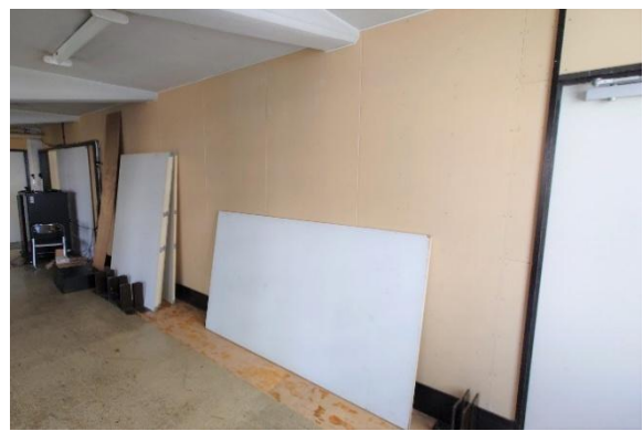
図10：26号室と旧傍聴席の間の仮設壁
