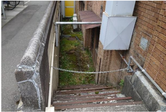
図 43：地下と 1 階屋内をつなぐ階段
