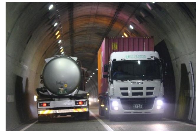
①トンネル内の大型車すれ違い困難
