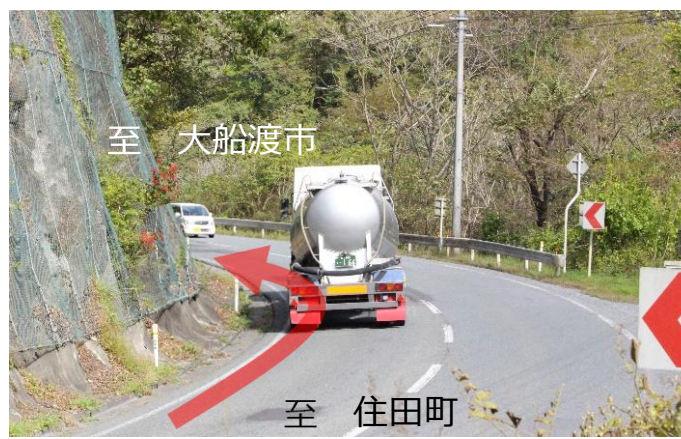
③急カーブ (最小曲線半径R=100m)
