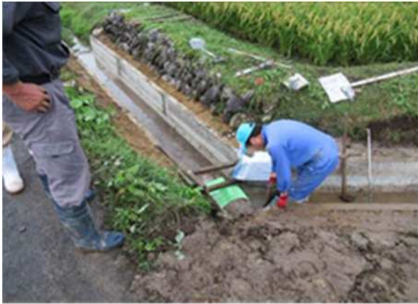
【老朽化した水路の補修】
