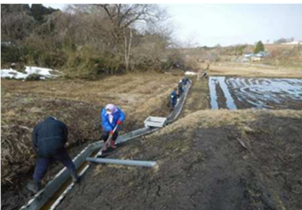
【老朽化した水路の更新】
