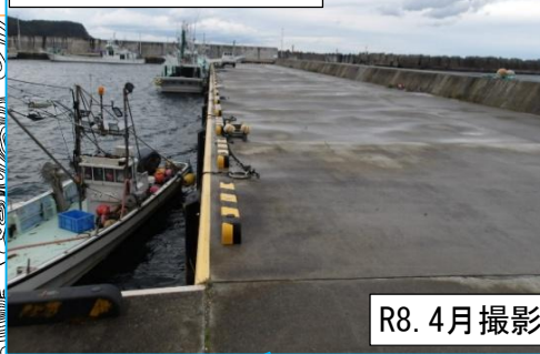
-3m岸壁・護岸(完成)
