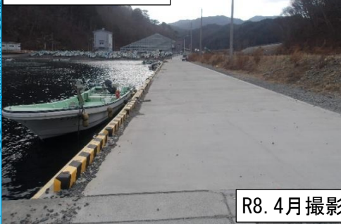
-2m物揚場(完成)
