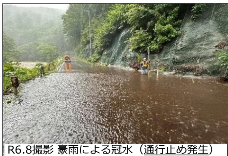
R6.8撮影 豪雨による冠水（通行止め発生）
