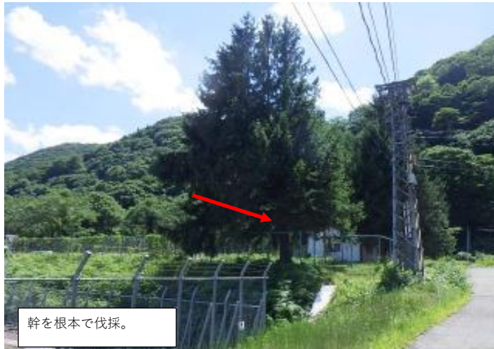
⑪県 1本 0号鉄塔付近
