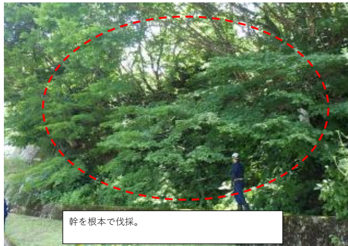
②共3 8本 発電所へ至る下り斜路の脇の法面
