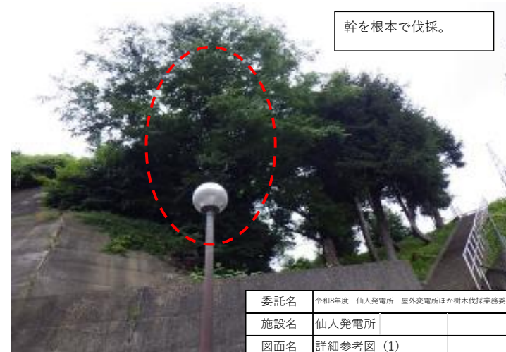
④共3 5本 屋外変電所への階段脇法面
