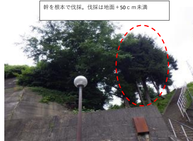
③共3 8本 屋外変電所への階段脇法面
