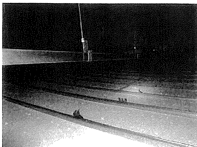
図 1 - 4 脱落部分以外の天井内クリップ外れ状況 2
