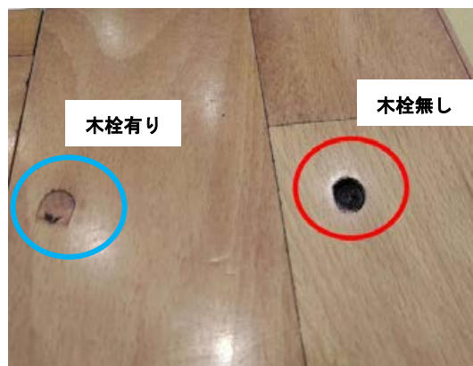
正常な木栓及び 木栓が紛失して露出したねじ頭
