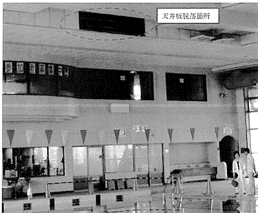
図 2-1 天井立ち上がり部脱落状況
