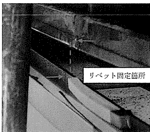
図 2-2 骨組み留め付けリベット抜け状況
