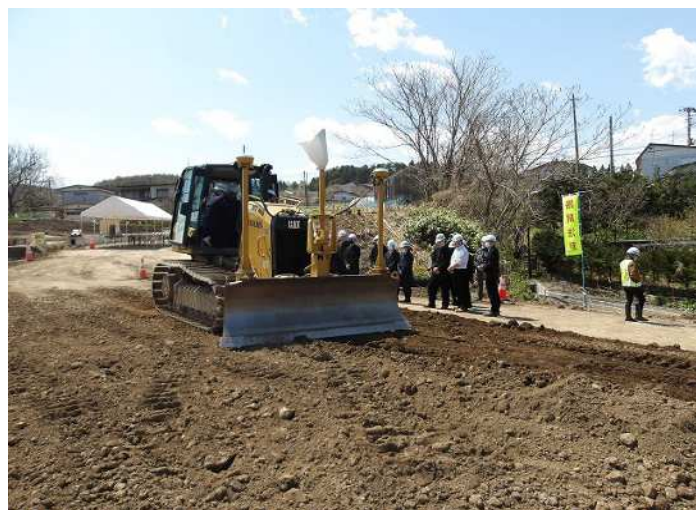
ICT建機搭乗体験(ブルドーザ)
