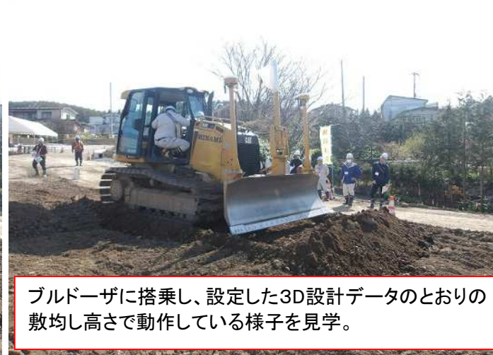
ICT建機搭乗体験(ブルドーザ)
