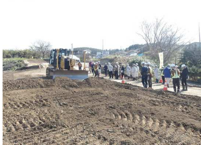
ICT建機搭乗体験(ブルドーザ)
