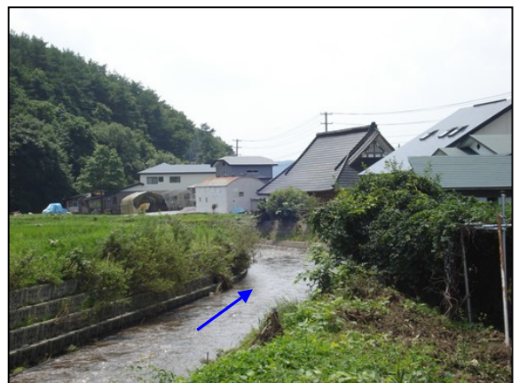
【未改修狭隘区間】
