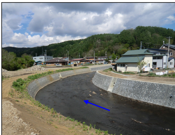
【改修済区間 (沼宮内工区)】
