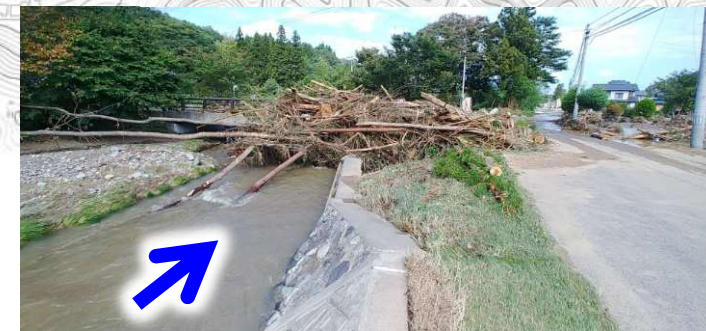
被災時の状況(小屋畑橋)
