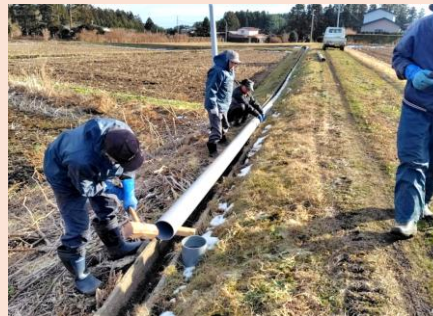
【多面的機能支払】水路の補修状況 (洋野町: 戸地区環境保全組合)
