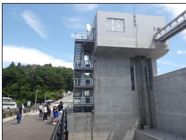
津波防災施設（野田水門）見学
