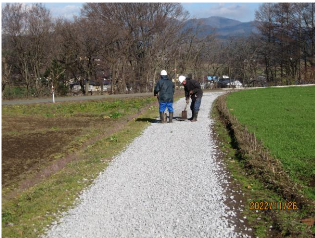
(農業者による農道への碎石舗装)
