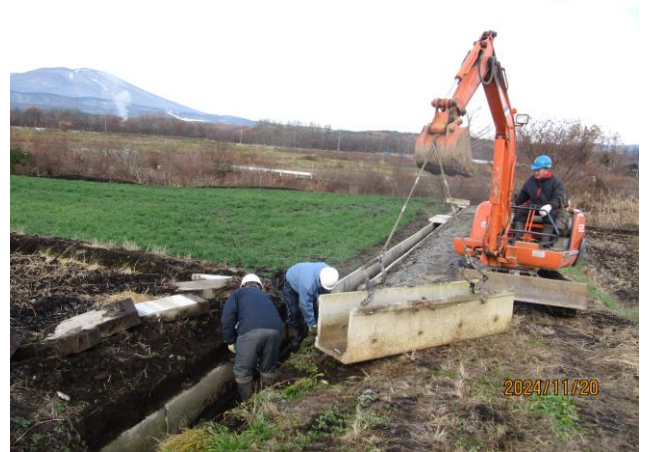
(農業者によるコンクリート水路への更新作業)
