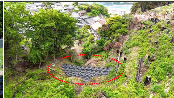
大型土のう等による応急対策
