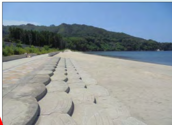
砂浜、スロープ等の復旧
