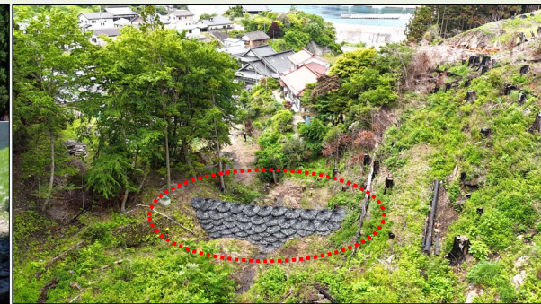
大型土のう等による応急対策
