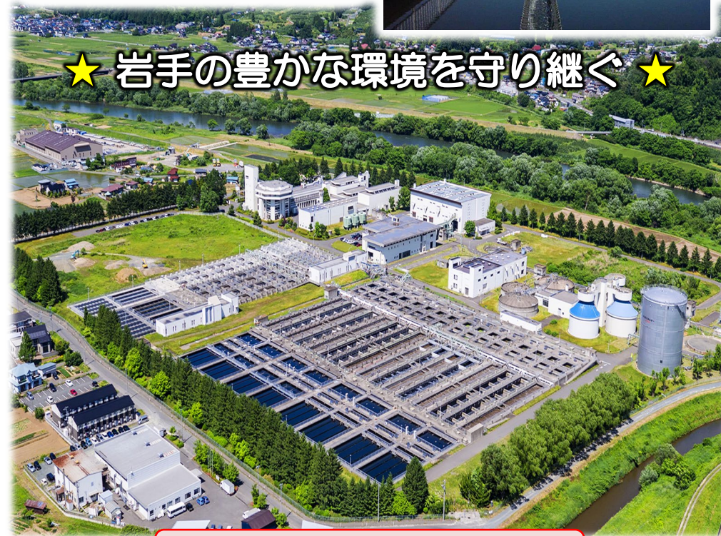
都南浄化センター（盛岡市）
