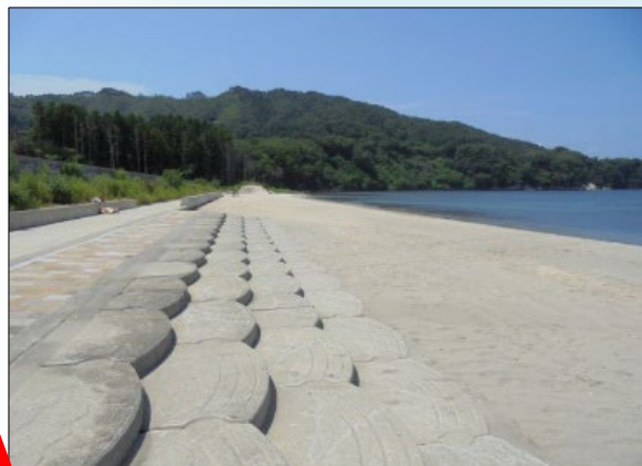
砂浜、スロープ等の復旧
