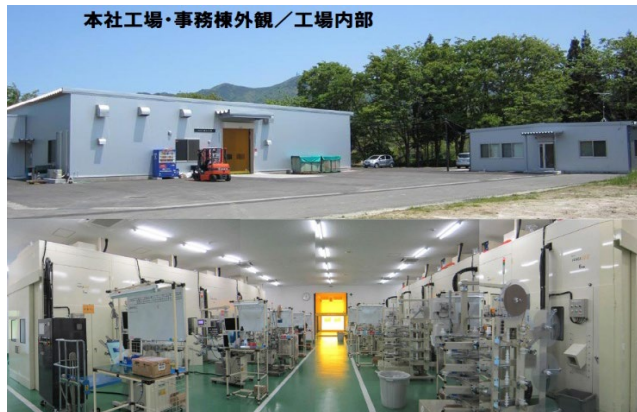
本社工場・事務棟外観／工場内部
