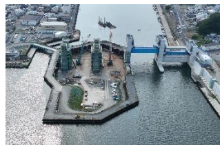
整備中の閉伊川水門（宮古市）
