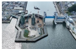
整備中の閉伊川水門（宮古市）
