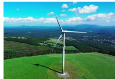
稲庭高原風力発電所
