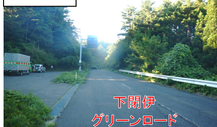
写真② 既設作業道
