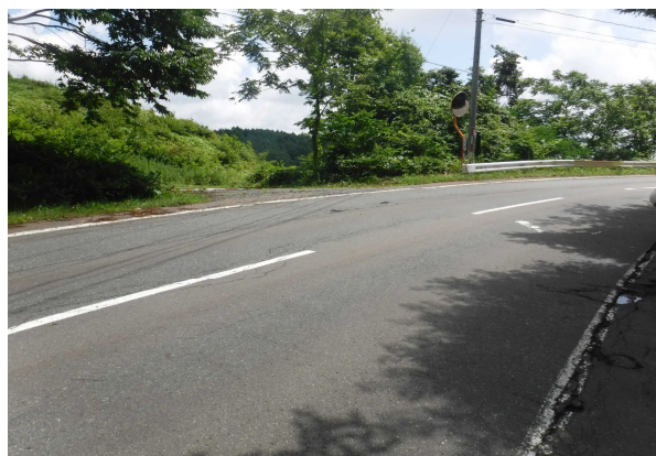
国道455号線からの林道取付状況
