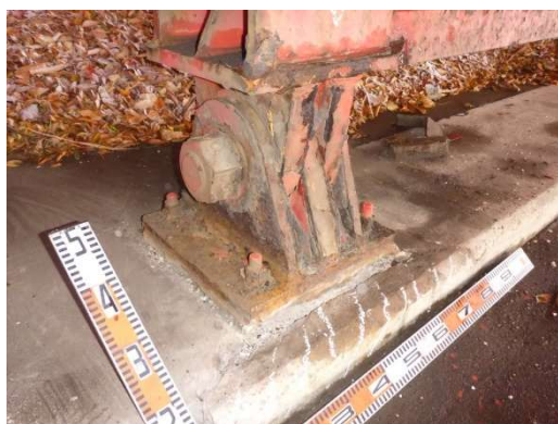
凍結抑制剤による損傷事例(鋼部材)
