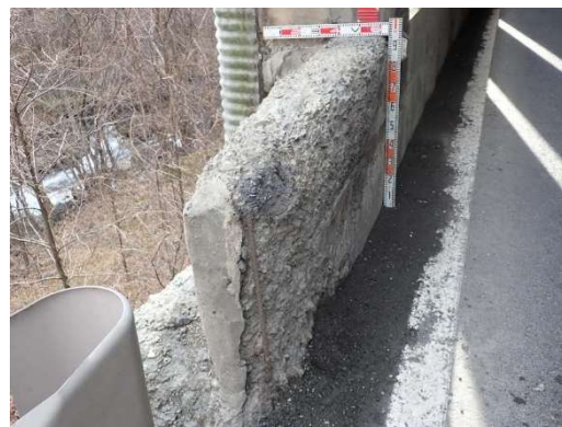
凍害による損傷事例(コンクリート部材)
