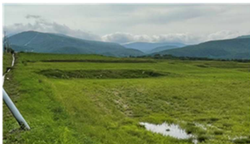
畦畔の一部を除去し傾斜を整地
