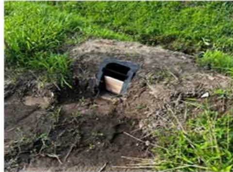
田んぼダム器具設置
