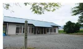
平倉地区消防コミュニティセンター
