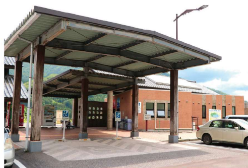
傘をさせない車椅子の方も、雨や雪を気にせず安全に移動できる屋根付きの駐車場
