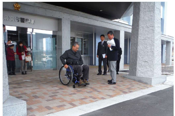
障がいのある方等から意見を伺いながら建築した 宮古警察署（スロープの傾斜を確認しているところ）
