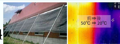
寒冷紗や遮熱塗料で牛舎内温度上昇を抑制
