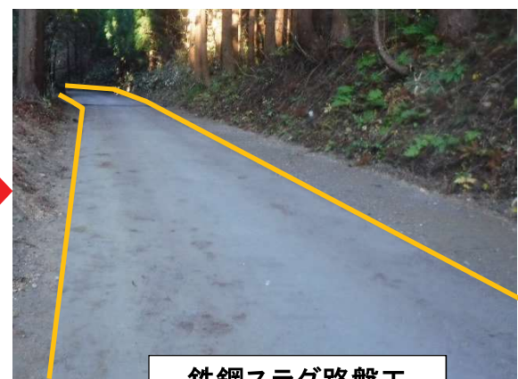
鉄鋼スラグ路盤工
