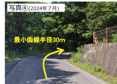
線形不良：最小曲線半径30m
