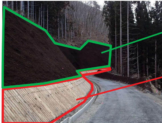
植生基材吹付工
