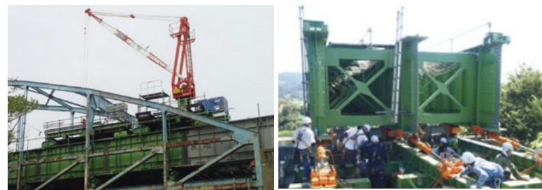
橋梁の上に工事桁を設置し、上部をクレーンが移動（主要地方道一関北上線 柵の瀬橋）
