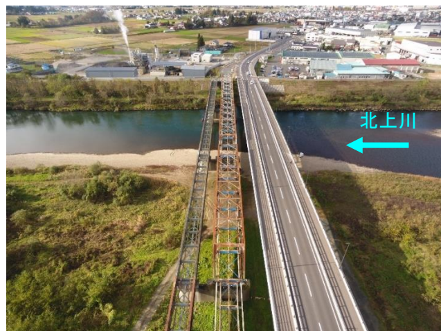
床版撤去後の徳田橋(全景)
