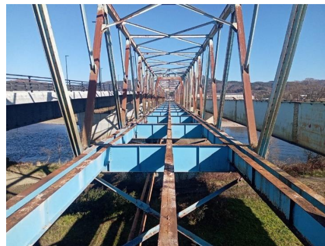
床版撤去後の徳田橋(近景)
