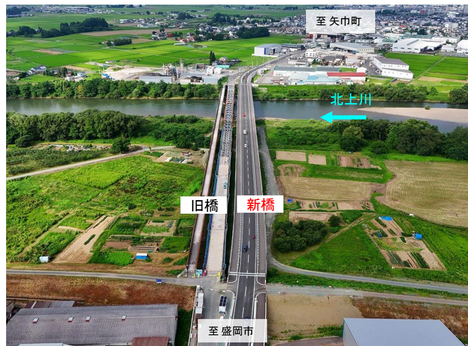
完成後の徳田橋（盛岡市から矢巾町方向を望む）
