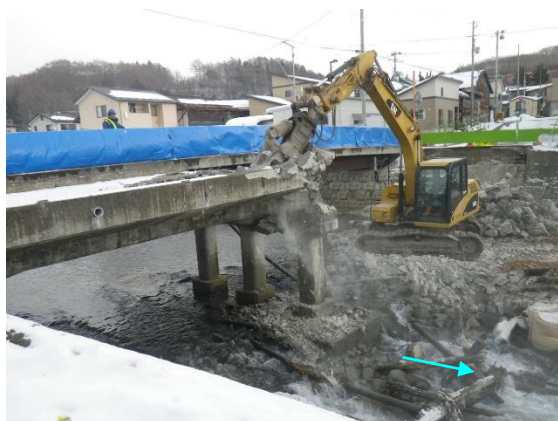
旧五日市橋撤去工事の状況
